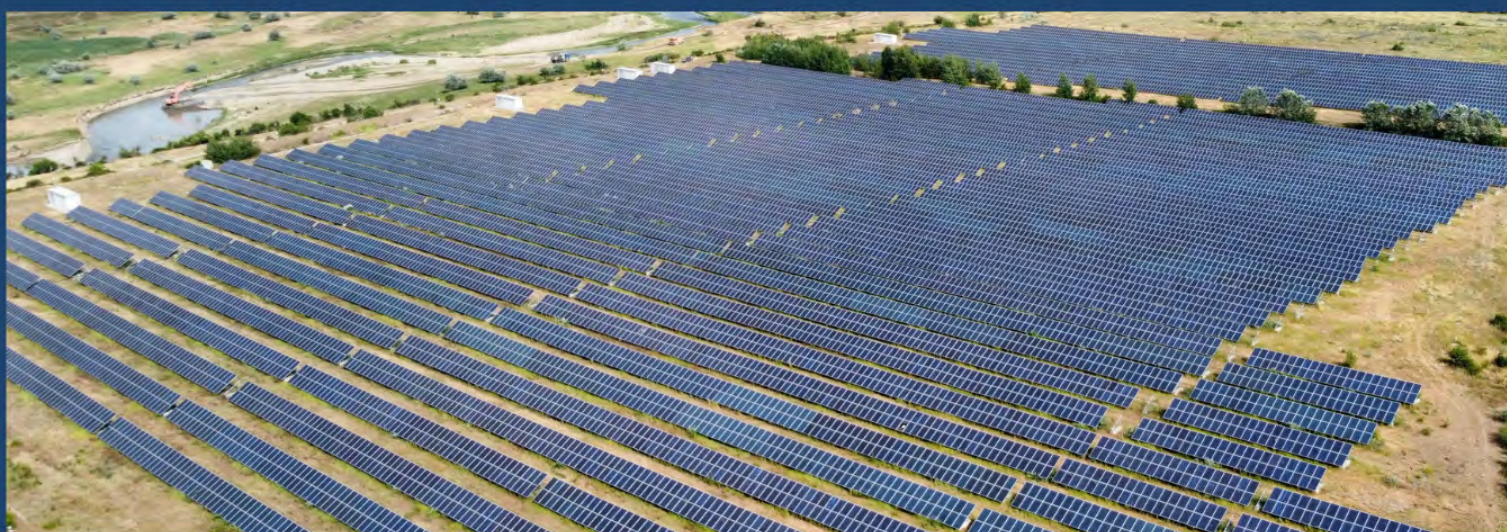
Parc solar al Premier Energy, județul Buzău, România
